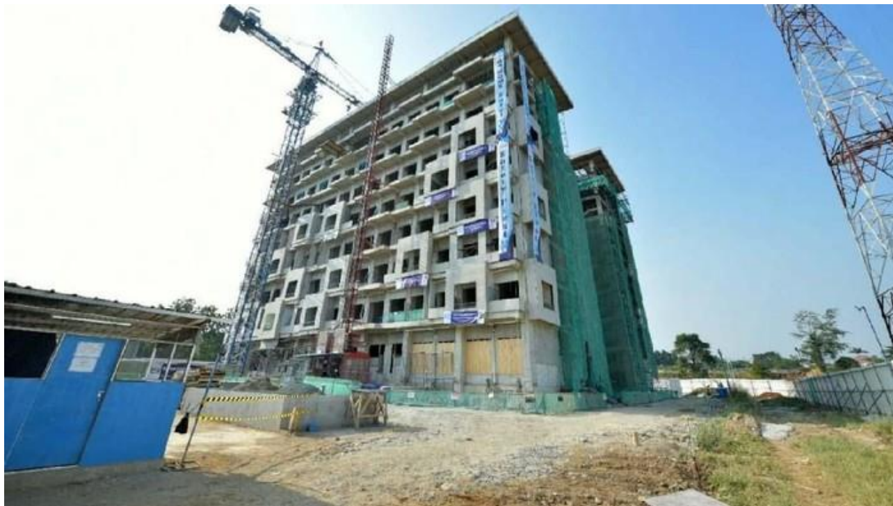
Pembangunan kampus UIII Depok. (Foto: Kementerian PUPR)
