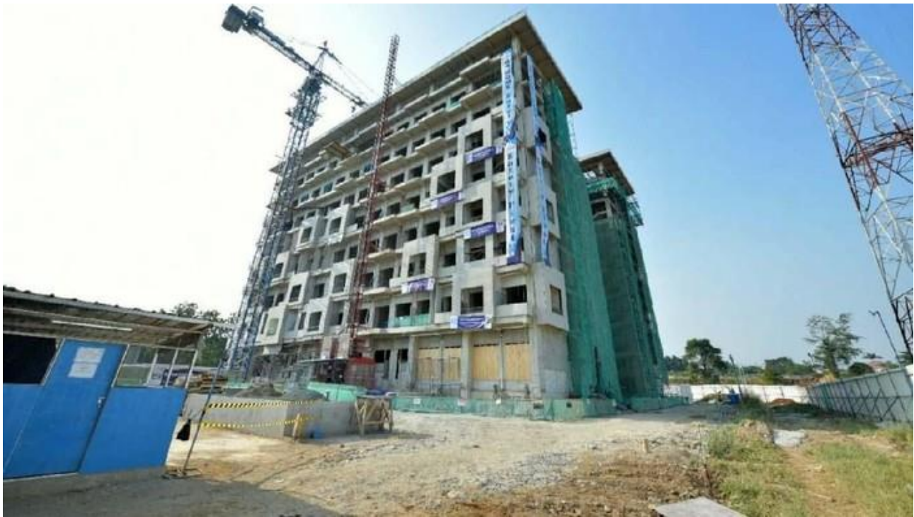
Pembangunan kampus UIII Depok (Kementerian PUPR)
